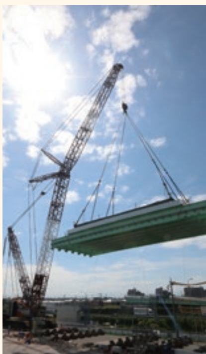
白岡宮代線の橋桁架設工事
