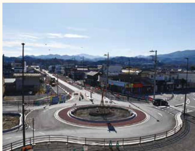
現在整備中の「寄居駅南口駅前広場」と「中央通り線」
