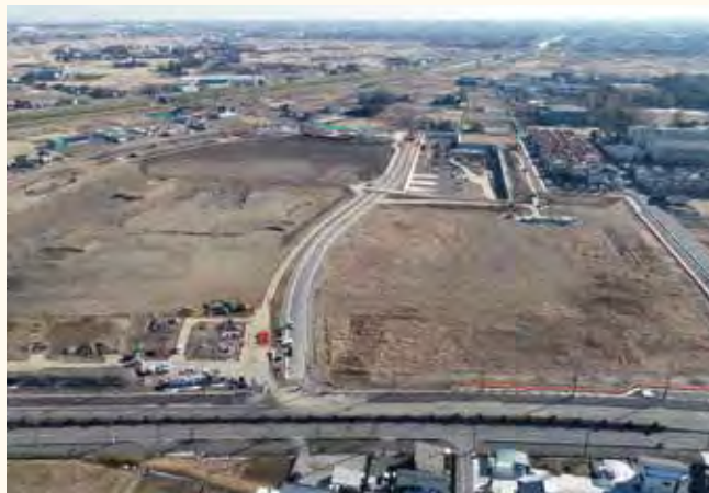
整備が進む松伏田島産業団地
